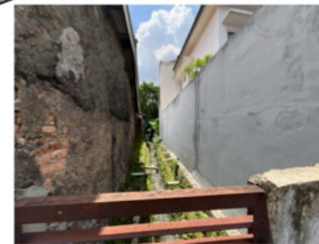
LOKASI 2 EX. RUMAH DINAS
