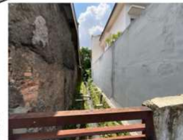
LOKASI 2 EX. RUMAH DINAS
